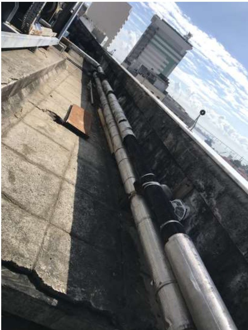
Figura 12 – Isolamento da Tubulação
