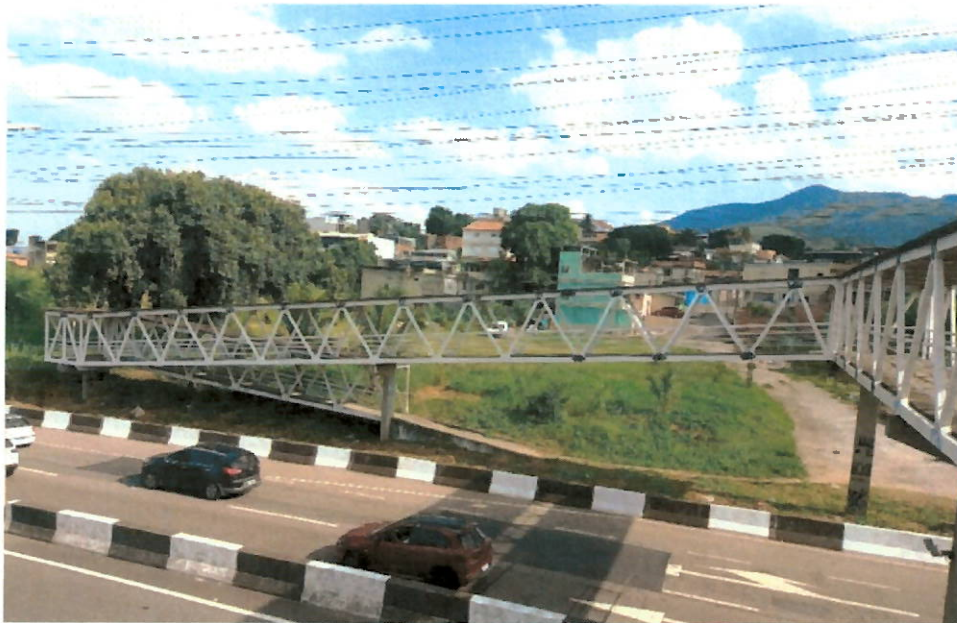
Figura 5 – Visão Geral da Passarela km 6+450 identificando o Acesso 1.
