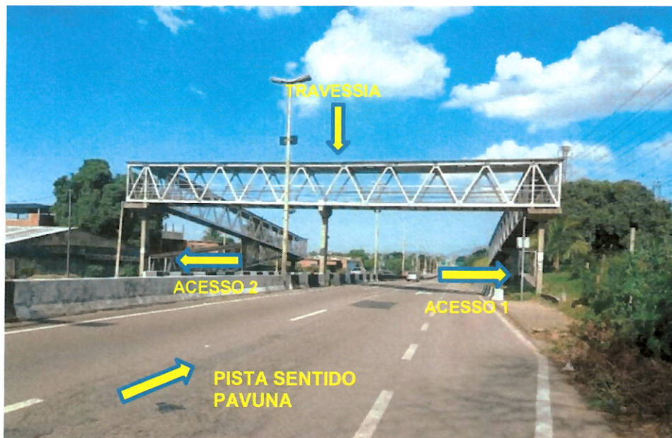
Figura 3 – Visão Geral da Passarela km 6+450.
