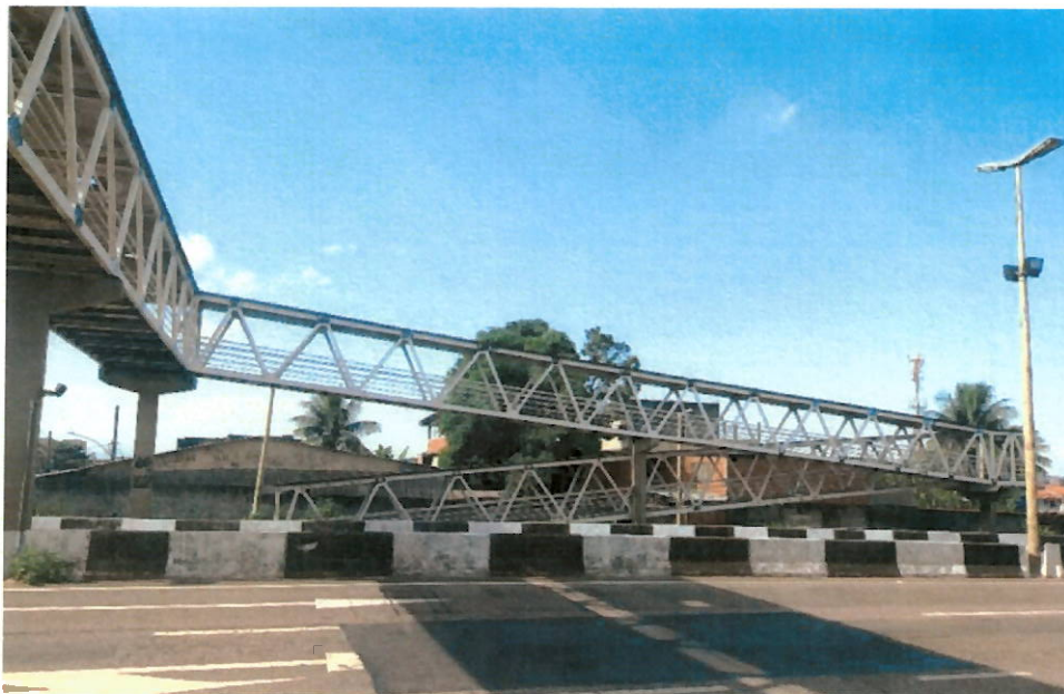
Figura 6 – Visão Geral da Passarela km 6+450 identificando o Acesso 2.
