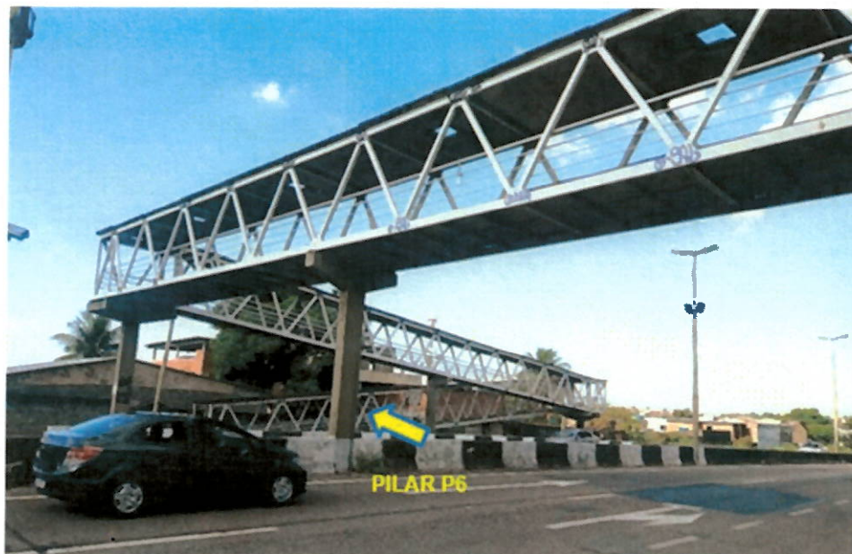
Figura 4 – Visão Geral da Passarela km 6+450.
