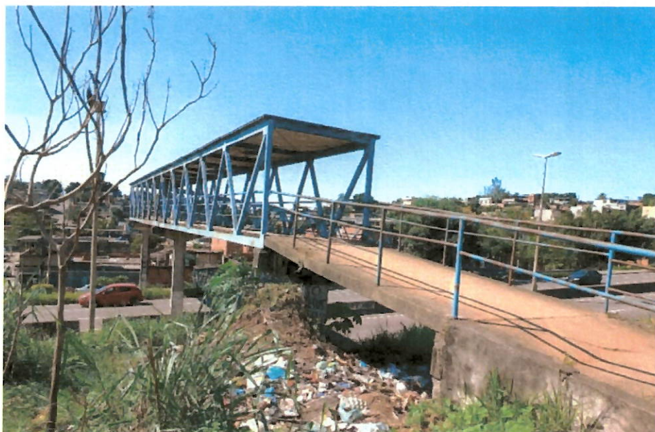
Figura 5 – Visão Geral da Passarela km 3+050 identificando o Acesso 1
