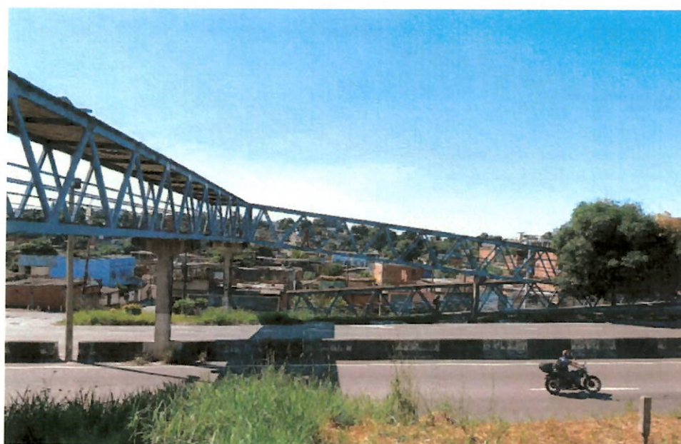
Figura 6 – Visão Geral da Passarela km 3+050 identificando o Acesso 2
