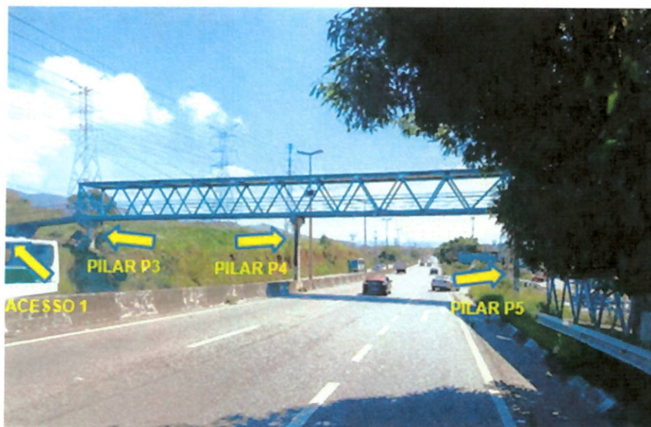
Figura 4 – Visão Geral da Passarela km 3+050
